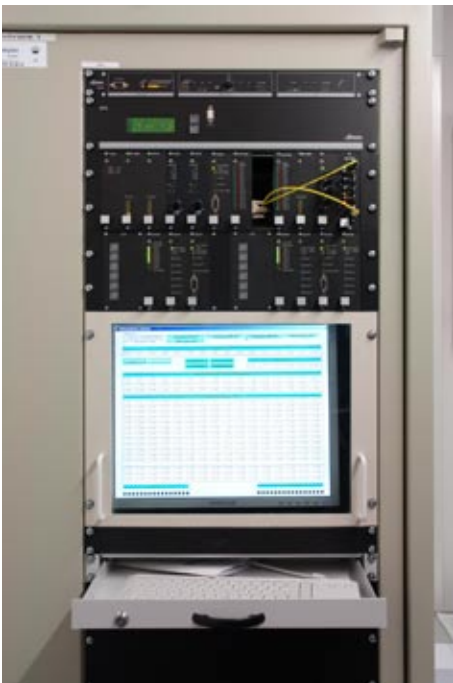
Zentralentechnik mit simax-Modulsystem, Steuerrechner und Endstufen
